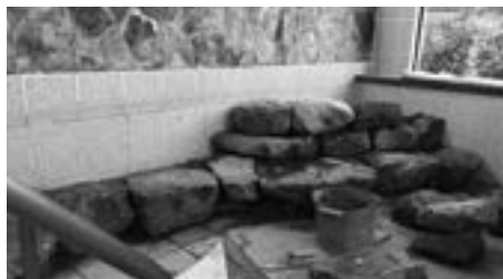
改修中の浴槽
