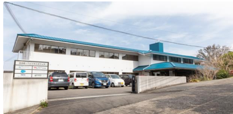
「白浜町ⅠTビジネスオフィス」。大手企業の旧保養所を改修して整備（事業費1.1億円、オフィスは5室）。
