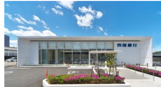
太陽光発電パネルの設置（小松島支店）
