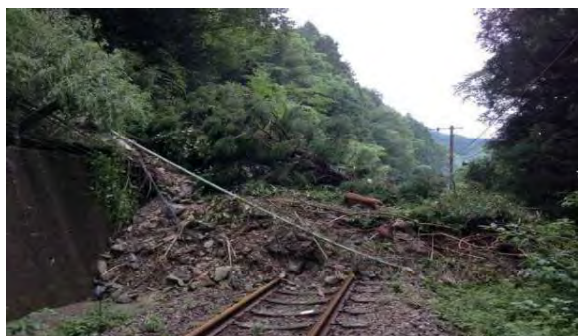
「土砂崩壊」の様子
