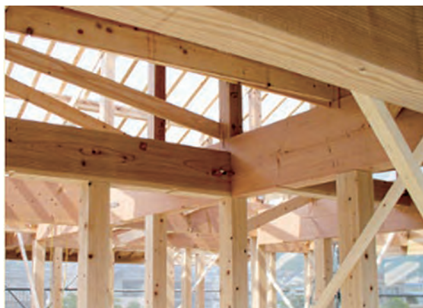
▲ 四万十町産の檜・杉を主に利用した在来軸組工法の「木の家」 資料：株式会社フタガミHPより
