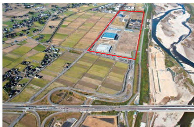
写真1-4 産業団地「IC パーク高岡」の外観 （赤線の囲み部分）
