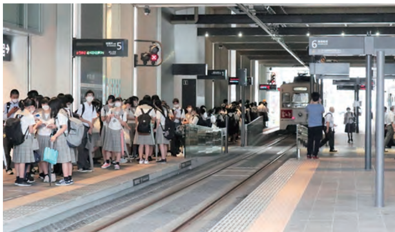
写真 1-1 富山駅の高架下に移設された路面電車停留場
