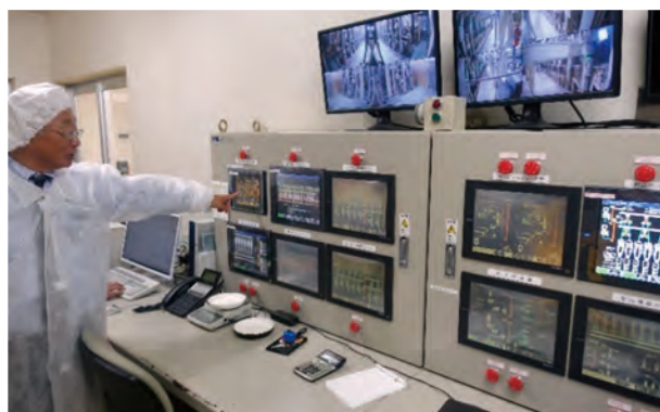
▲ オペレーター室
