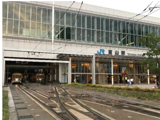
写真 2-3-8 JR 富山駅高架下にある 富山地方鉄道市内線の停留所
