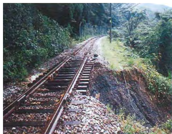
写真 2-3-10 大雨による土讃線の被災状況(1998 年)
