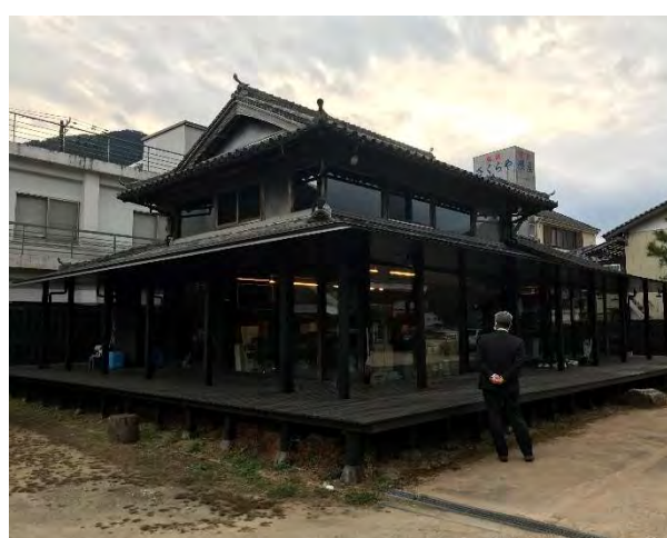
写真Ⅳ-9 えんがわオフィス
