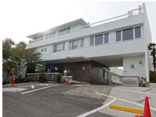
写真Ⅲ-5 ANCHOR 外観
