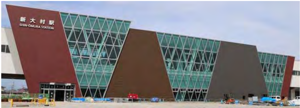
写真 1-21 新大村駅の外観
