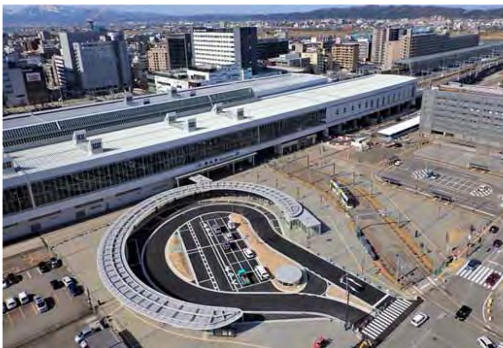
写真 1-4 富山駅北口広場の様子
