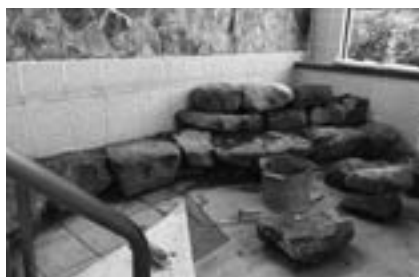
改修中の浴槽
