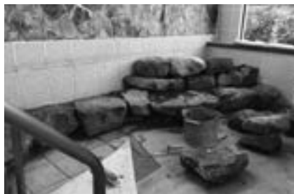
改修中の浴槽
